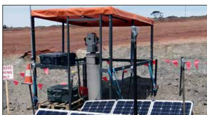
安装I-Site™ 8820激光扫描仪，扫描现场
